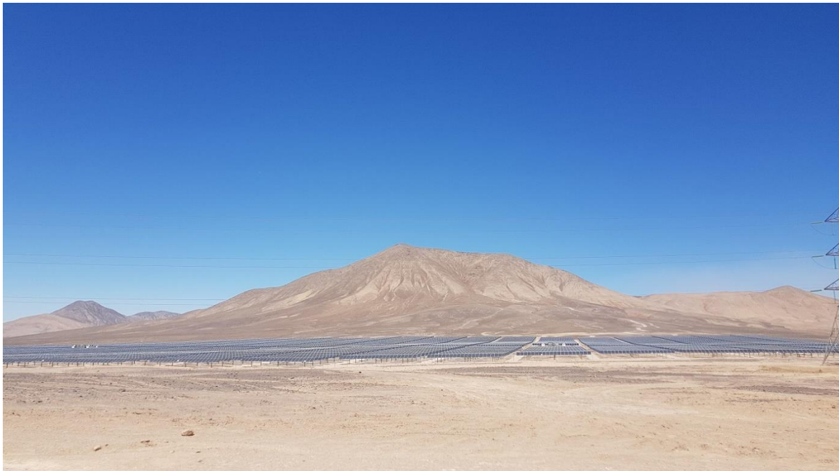
Solpark i Atacamaöknen, en viktig del i Chiles omställning till förnybar el och klimatneutralitet
